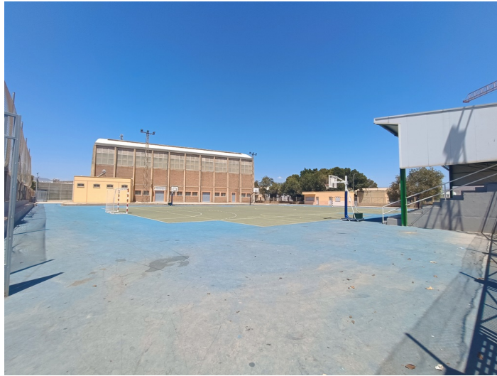
Terrenos de pistas polideportivas Calle Málaga
