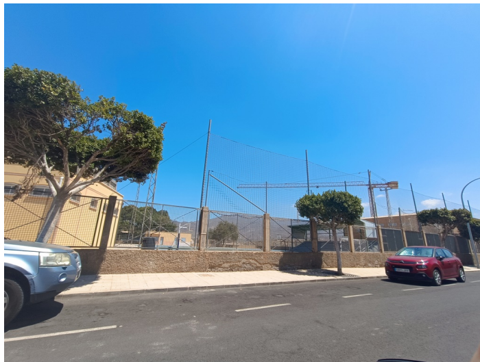
Terrenos de pistas polideportivas Calle Málaga
