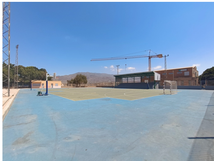
Terrenos de pistas polideportivas Calle Málaga
