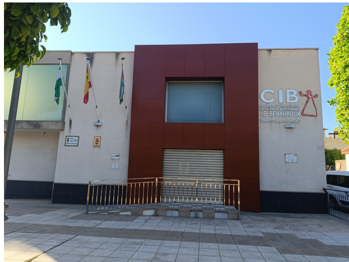
Fachada exterior edificio
