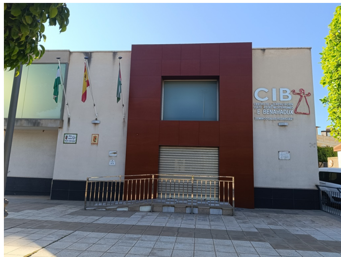
Fachada exterior edificio
