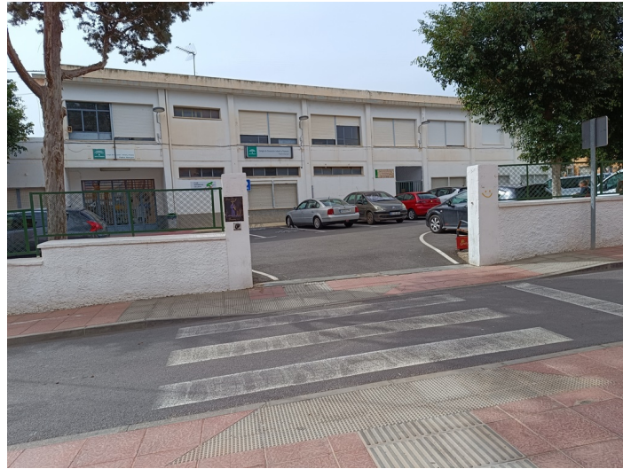
Fachada desde exterior del recinto
