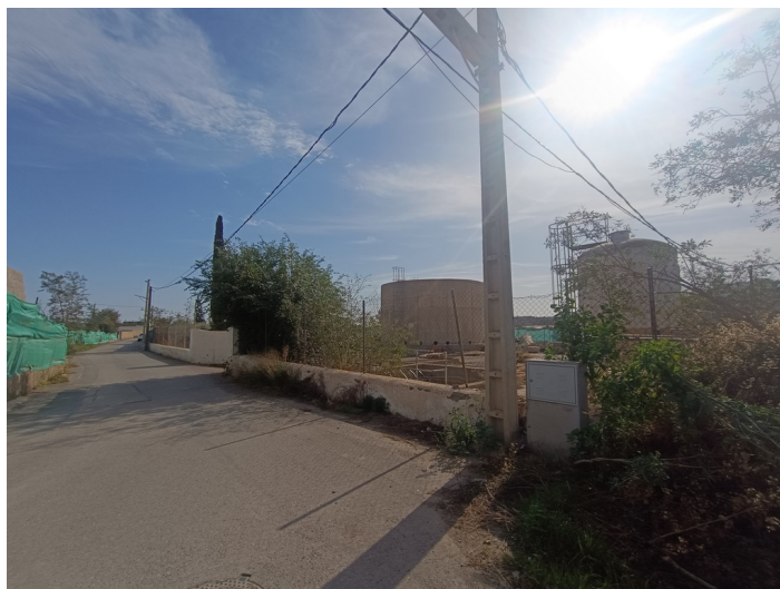
EDAR Estación Depuradora DS. CM Pechina
