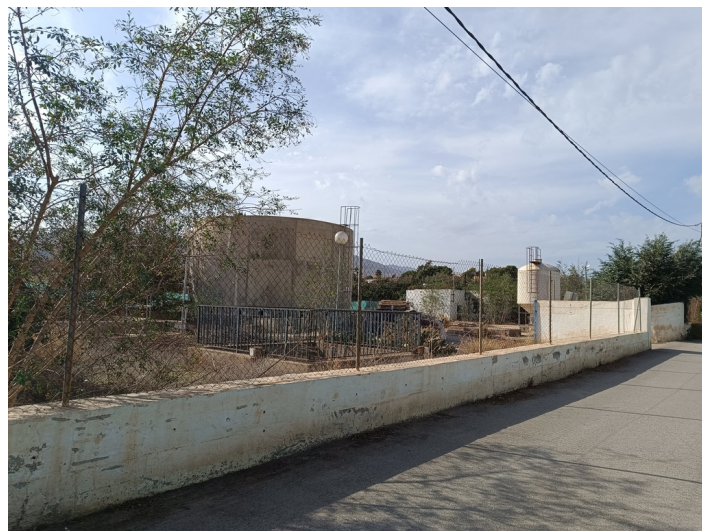
EDAR Estación Depuradora DS. CM Pechina
