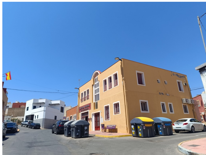
Terreno Centro de la juventud, biblioteca municipal y almacén
