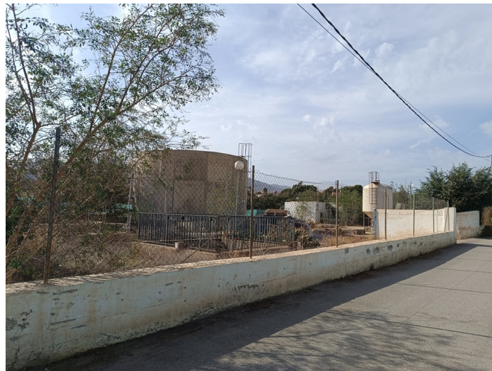
Terreno EDAR Estación Depuradora DS. CM Pechina
