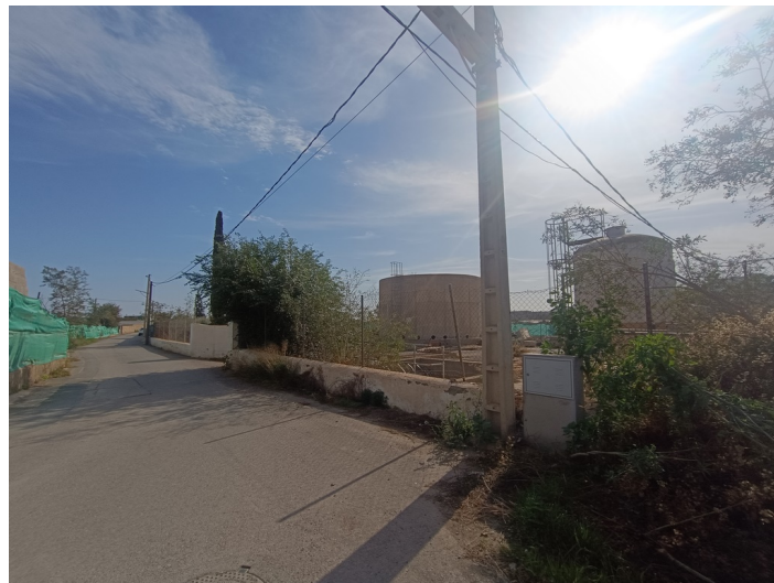
Terreno EDAR Estación Depuradora DS. CM Pechina
