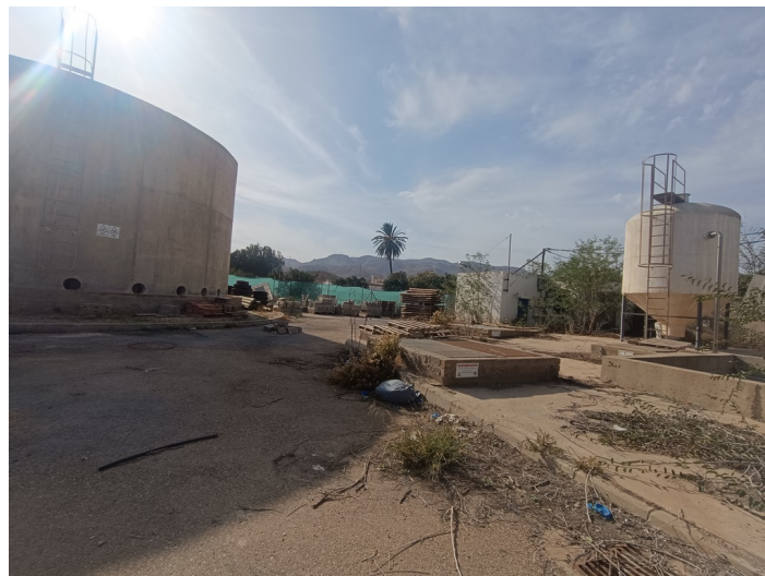
Terreno EDAR Estación Depuradora DS. CM Pechina
