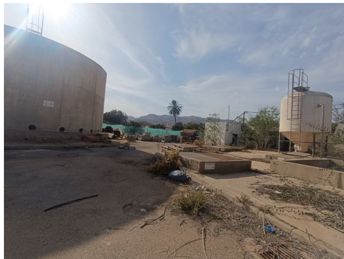
Terreno EDAR Estación Depuradora DS. CM Pechina
