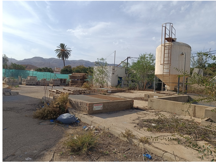
Terreno EDAR Estación Depuradora DS. CM Pechina
