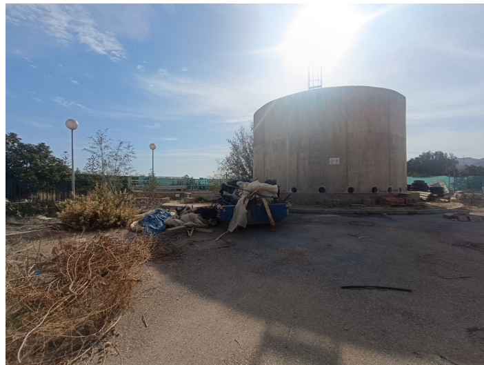
Terreno EDAR Estación Depuradora DS. CM Pechina
