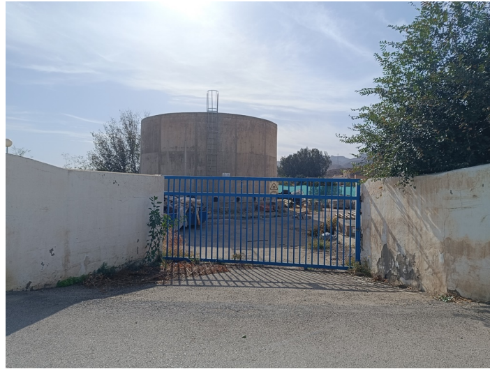
Terreno EDAR Estación Depuradora DS. CM Pechina
