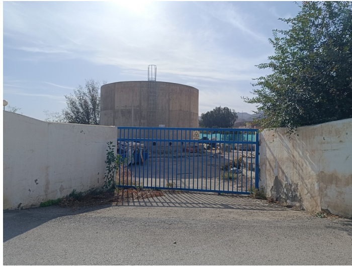
Terreno EDAR Estación Depuradora DS. CM Pechina
