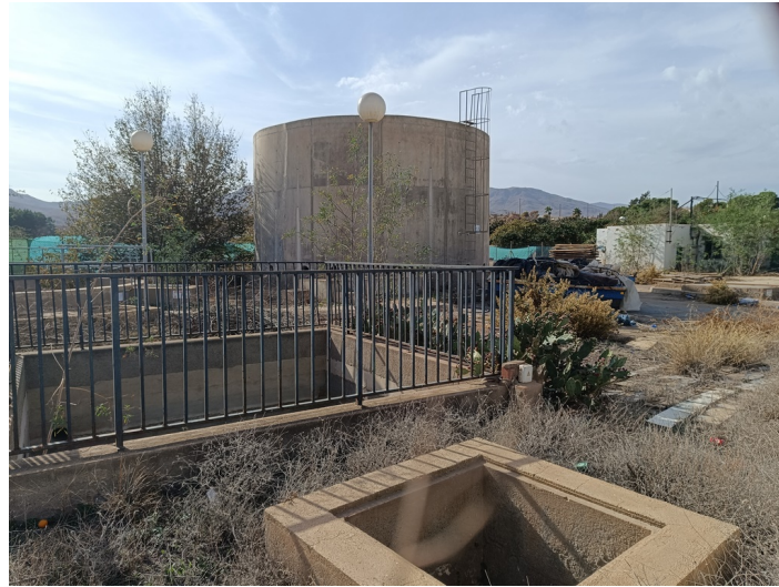
Terreno EDAR Estación Depuradora DS. CM Pechina
