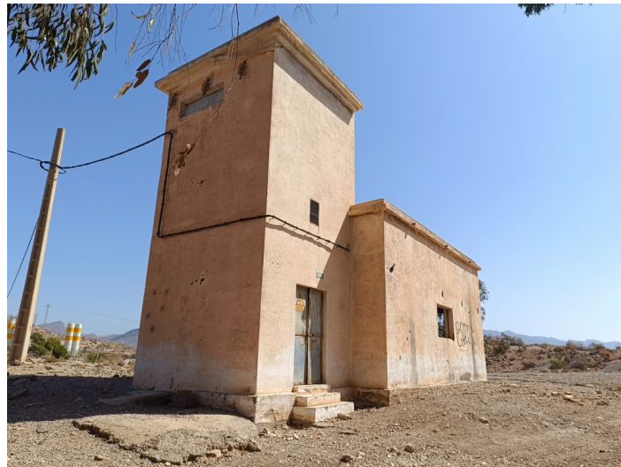
Terreno Transformador eléctrico DS La Viña
