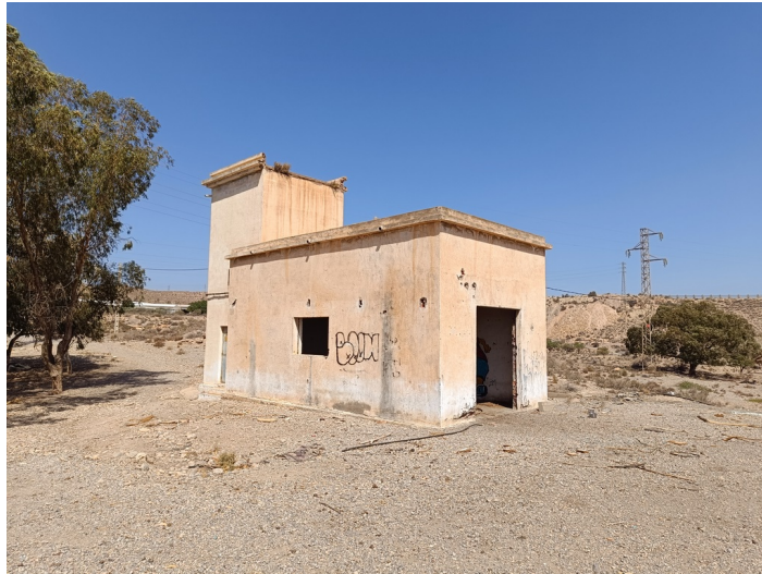
Terreno Transformador eléctrico DS La Viña
