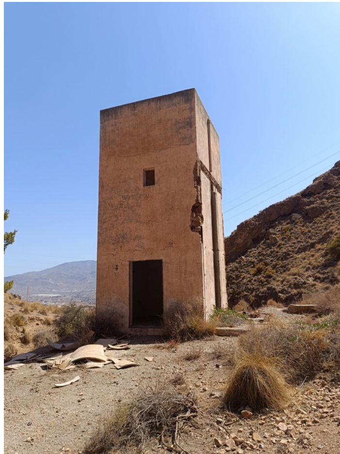
Terreno Transformador eléctrico DS La Viña 4
