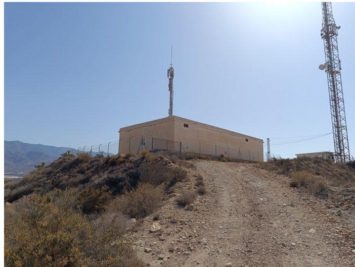
Terreno Depósito Nuevo para el Agua
