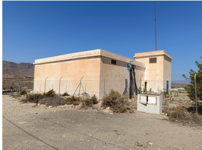
Terreno Depósito Nuevo para el Agua
