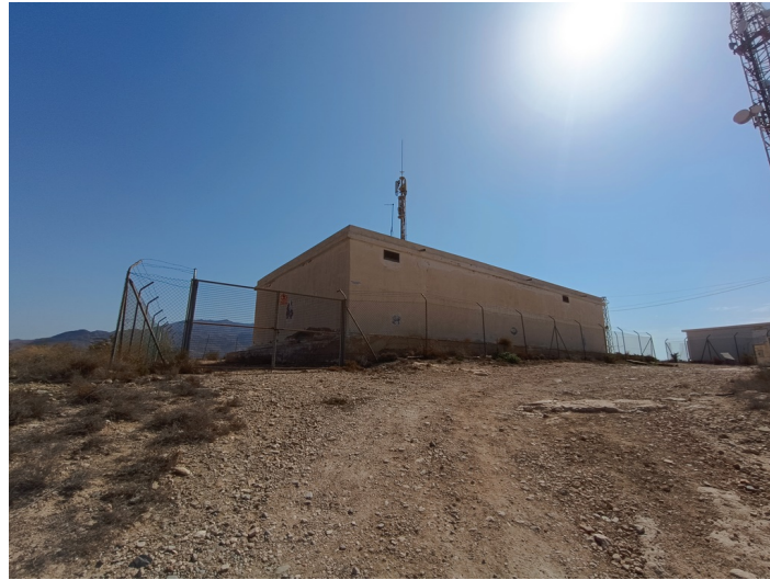
Depósito Nuevo para el Agua
