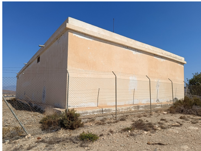
Depósito Nuevo para el Agua
