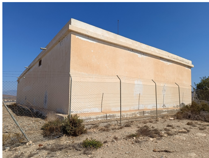
Depósito Nuevo para el Agua
