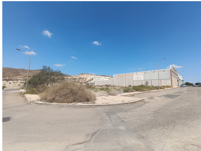
Solar Polígono Sector I-4 Finca P2
