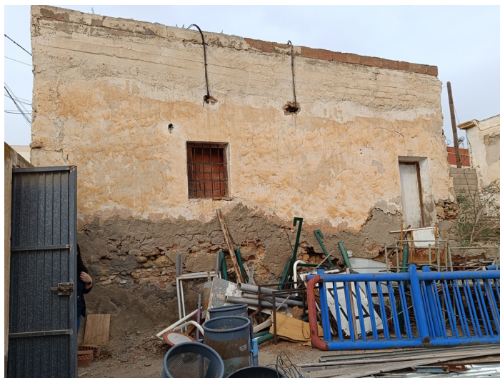
Fachada desde Almacén
