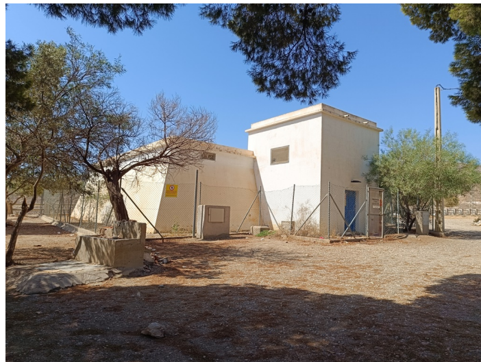
Depósitos Viejos de Agua
