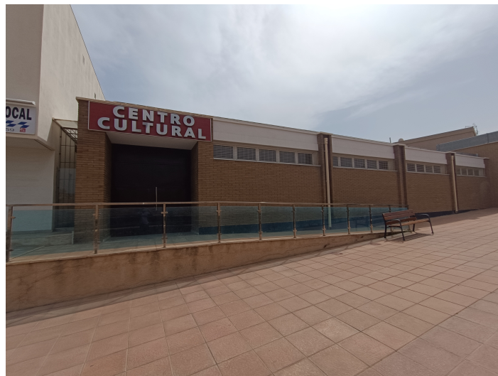
Vista exterior fachada
